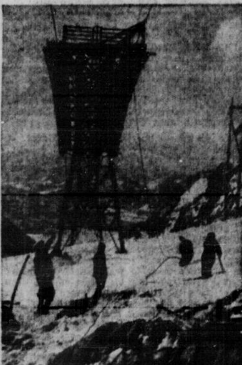
Für bequeme „Bergsteiger“ Der Bau der neuen Nebelhorn-Seilbahn in Oberstdorf Der Bau der neuen Nebelhorn-Seilbahn, die von Oberstdorf auf 2000 Meter Höhe führt, geht seiner Vollendung entgegen. Man hofft, die Bahn zu Ostern dem Verkehr übergeben zu können. Unser Bild zeigt die höchste Spitze der im Bau befindlichen Bahn.
