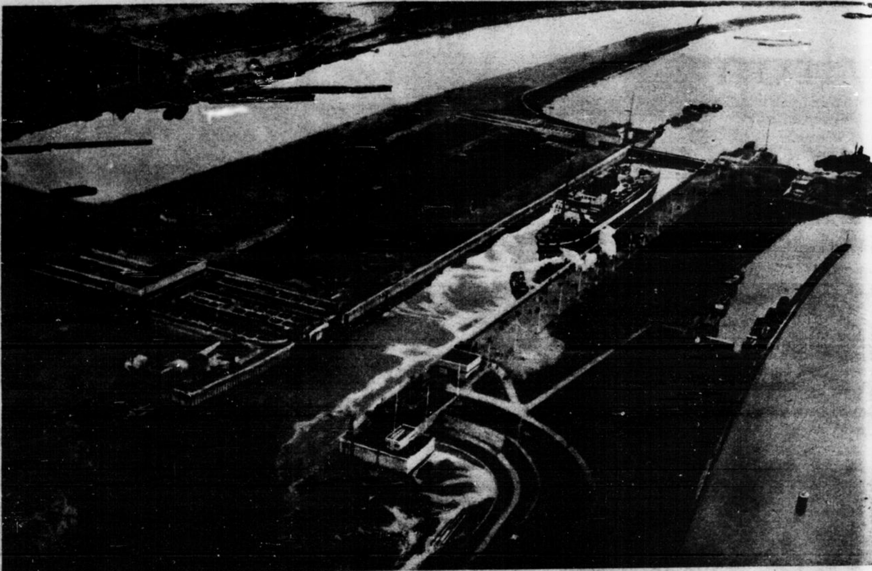
Die neue gigantische Schleuse von IJmuiden Die nördliche Schleuse des Hafens von IJmuiden, des Vochafens von Amsterdam, wurde in Anwesenheit der Königin der Nieder- lande eröffnet. Als erstes Schiff durchfuhr der große Passagierdampfer „Johann van Oldenbarnevelt“ mit der königlichen Familie an Bord die Schleuse auf der Ausreise nach Niederländisch-Indien
