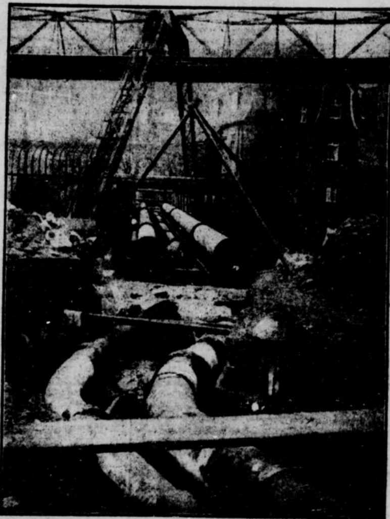
Die Wasserrohrbrücke über der Wupper an der Kabelstraße.
