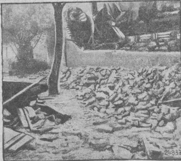
Der Mauereinsturz in Greifswald.
