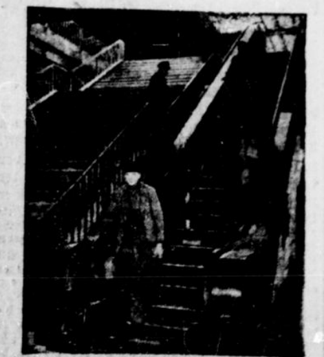
Auf dem neuen Bahnhof „Kuchellang“ der Berliner Stadt- und Ringbahn wurde erstmalig im Bereich der deutschen Reichsbahn eine Rolltreppe gebaut, die zwei Bahnsteige miteinander verbindet.
