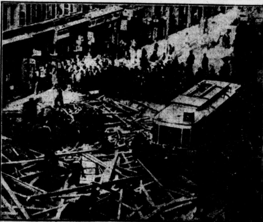
Das Bild zeigt die Trümmer des Holzgerüsts, unter dem zahlreiche Arbeiter und Passanten begraben wurden, rechts die Straßenecke, die im Augenblick des Einsturzes noch zum Stehen kam und knapp dem Verderben entging.
