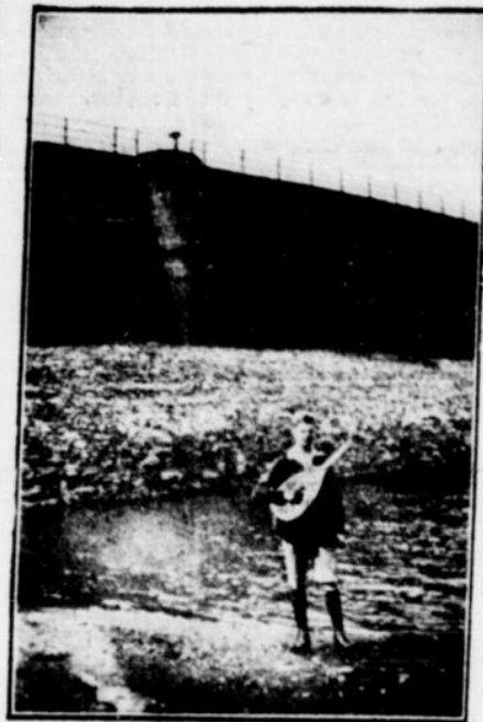
Die trodenelegte Bevertalperre.
