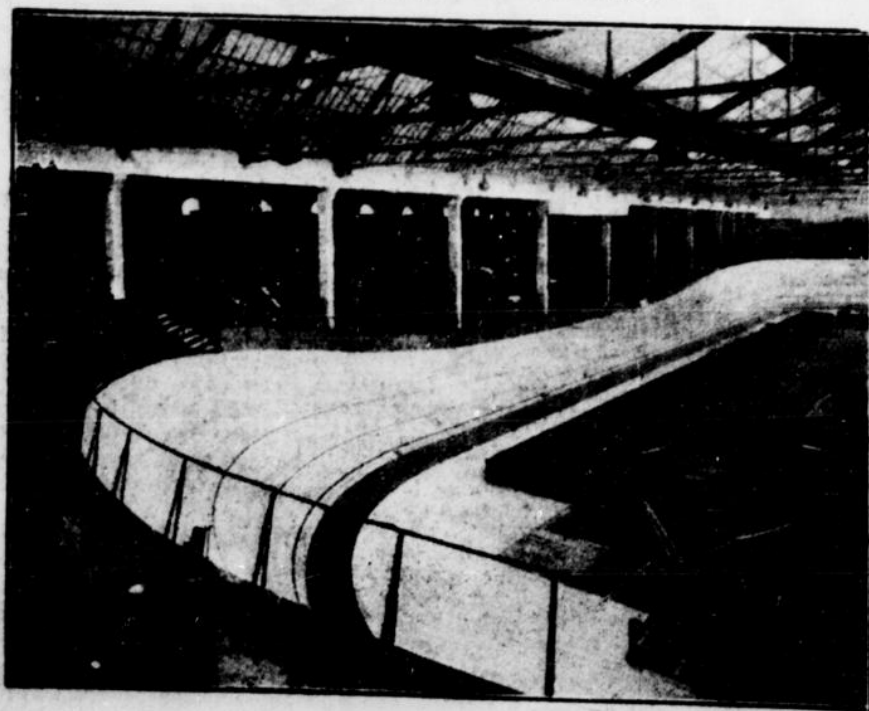
Die neue Rheinlandhalle in Köln.
