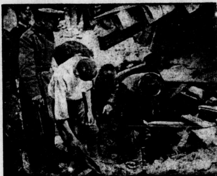
Beim Einsturz der Genossenschaftskasse in Tschirpan wurde der Kassierer im Treppenturm verschüttet und erst nach acht- undzwanzig Stunden unterlebt hervorgeholt.
