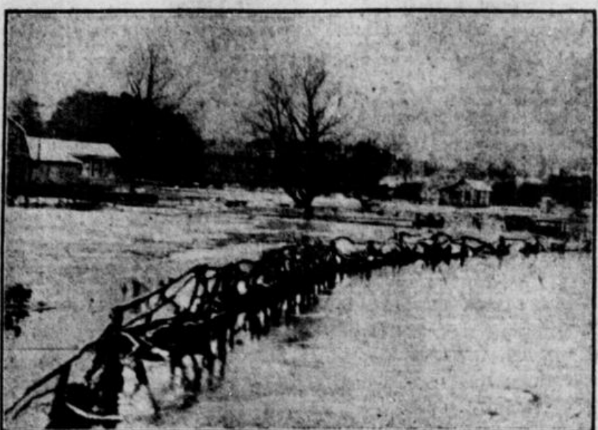
Im Kreise Stabe, unweit von Hamburg, stehen die niedrigegelegenen Cristelle völlig unter Wasser. Zahlreiche Häuser, die das Wasser unterpflügt hat, broden einzukünnen. Unser Bild zeigt eine in einen See verwandelte Straße an der Unterelbe.
