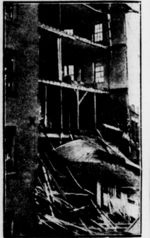
Ein von Anarchisten im Hofen durch Bomben zerstörtes Haus.
