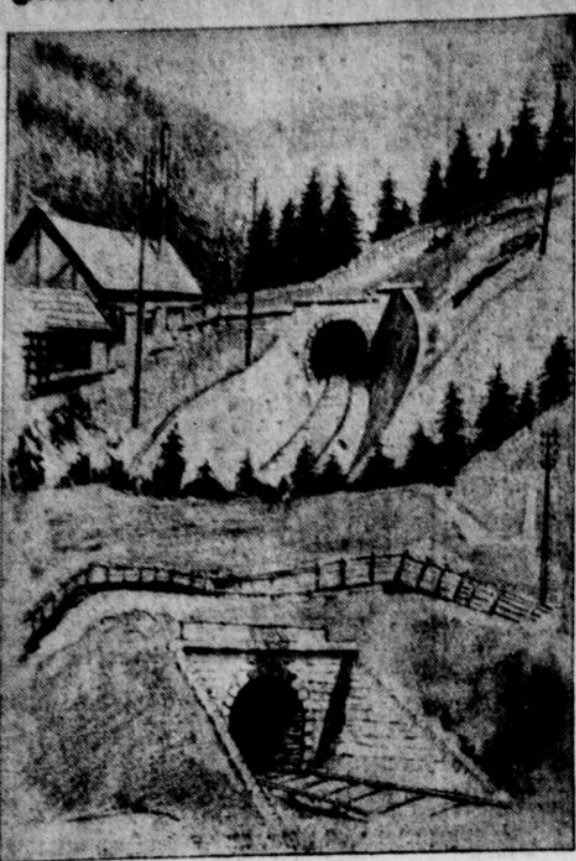
Unter Bild zeigt den Räder-Tunnel bei Rastbrunn, in dem das Personal eines Güterzuges, im ganzen neun Personen, ertrank.
