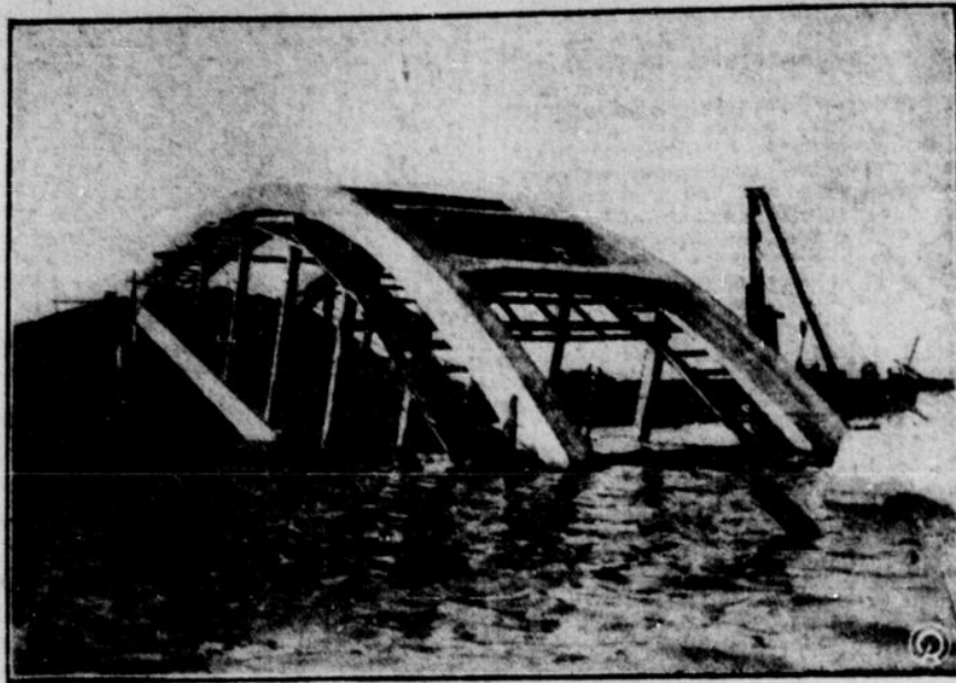
Die Brücke in Garg an der Oder ist acht Tage vor der Einweihung eingestürzt. Unser Bild zeigt den mitgerissenen seitlichen Bogen.
