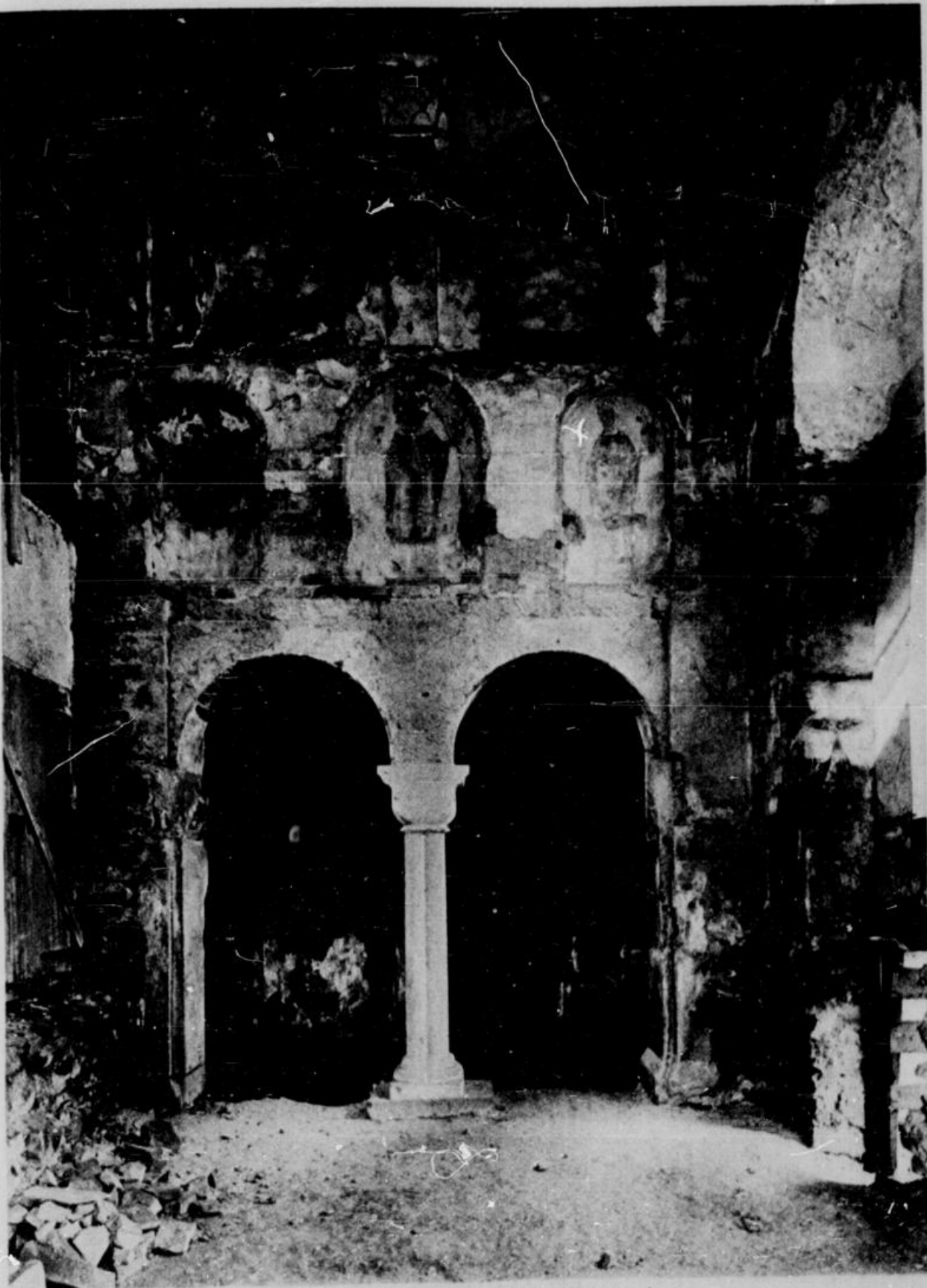
Chem. Luciuskirche in Werden (Ruhr) Inneres des Chores (erbaut nach 995). Ein leider dem Verfall geweihtes hochwertiges Baudenkmal
