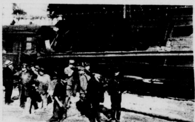
Zu der Entgleisung des Luxusjuges Paris-Rom in St. Margherita Ein zerstörter Wagen des Juges
