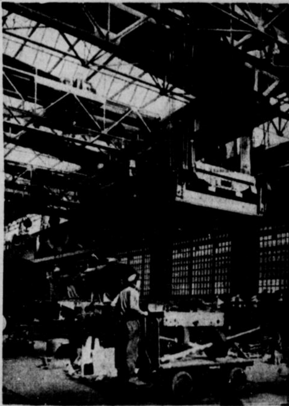
Heben einer Lokomotive mit zwei Hebekränen von zusammen 100 000 kg Tragkraft
