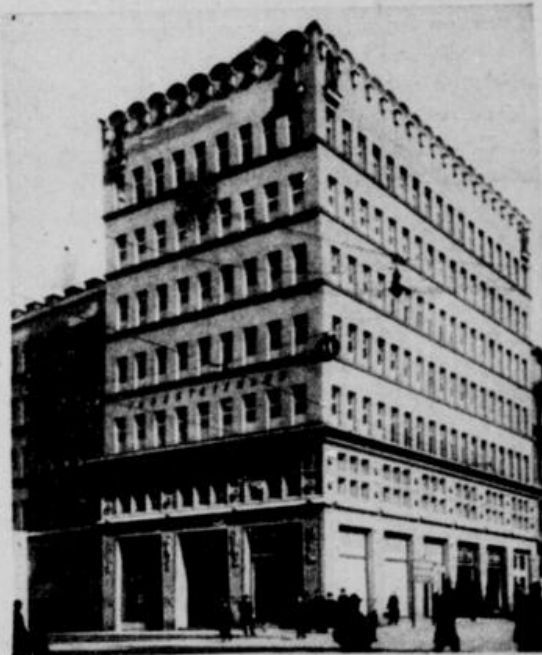
Düsseldorf: Das Industriehaus am Wehrhahn Architekten: Tietmann und Haake
