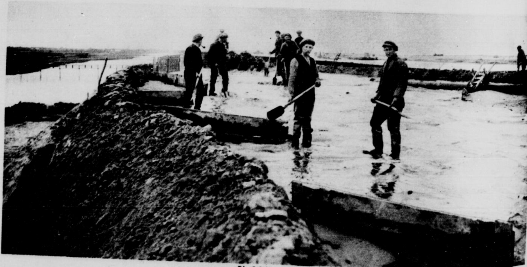
Die Arbeiten am Damm
