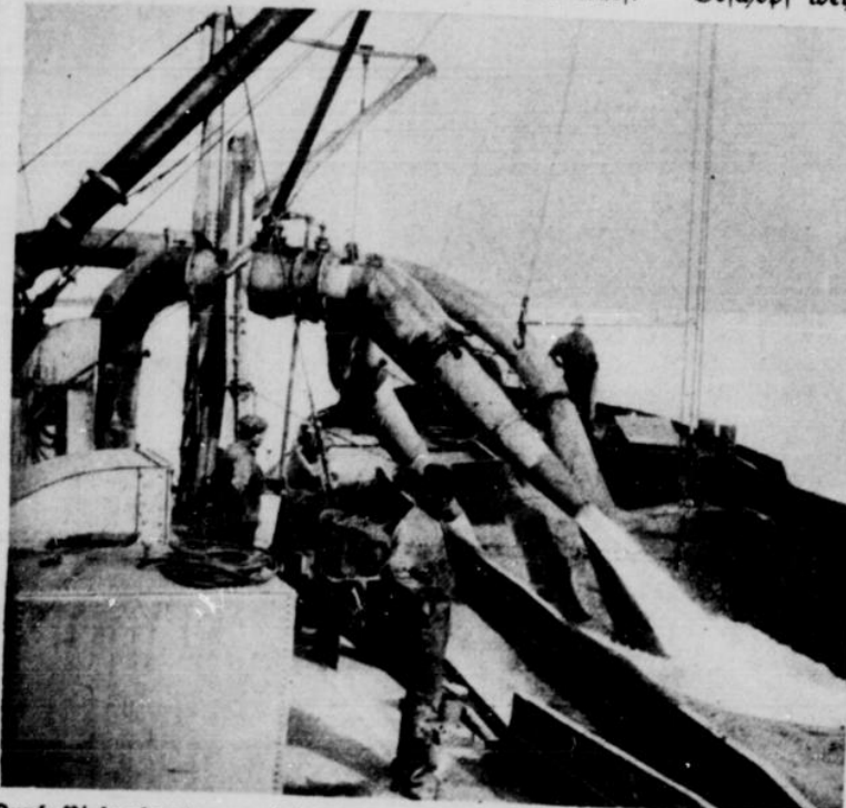
Durch Riesenelevatoren wird Sand gesaugt und dieser dann aufs Neue mit Wasser gemengt und zur Auffüllung der Räume zwischen den Deichen verwendet
