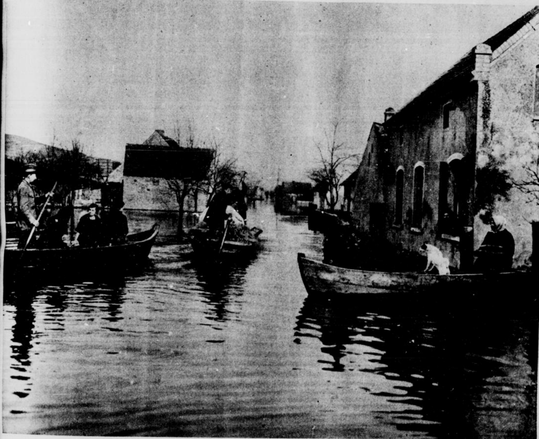
Die Überschwemmung im Warthebruch Der Verkehr in Zochow wird mittels Rähnen aufrecht erhalten
