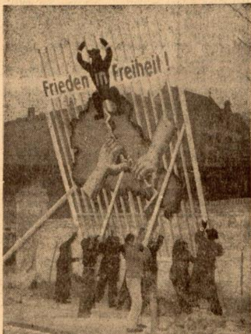
Neue Tafeln an der Sektorengrenze Der Bürgermeister des Westberliner Bezirks Kreuzberg, Willi Kressmann, ließ an der Sektorengrenze zum sowjetischen Sektor neben dem Grenzschild eine große Holztafel errichten. Das 4 mal 4 Meter große Schild steht unmittelbar an der Oberbaumbrücke und zeigt einen Berliner Bären, der eine Kette zerrissen hat. Zwei Hände reißen symbolisch die Mauer ein, die Berlin in zwei Hälften teilt. Das Schild trägt die Aufschrift „Wir sind uns einig“. In der unteren Zeile steht „Frieden in Freiheit“. Ein ähnliches Schild soll noch in der Stresemann-Straße in der Nähe des Potsdamer Platzes aufgestellt werden. (Bild: dpa)
