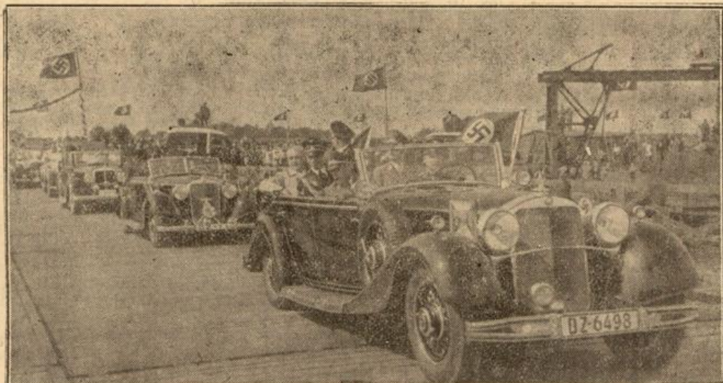
Die neue Pontonbrücke über die Weichsel eingeweiht
