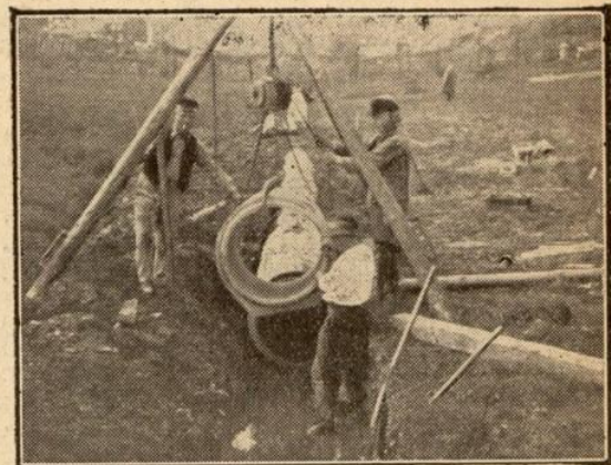
Rohrleger in der Dorfweide bei der Arbeit. (Photo: Bell)
