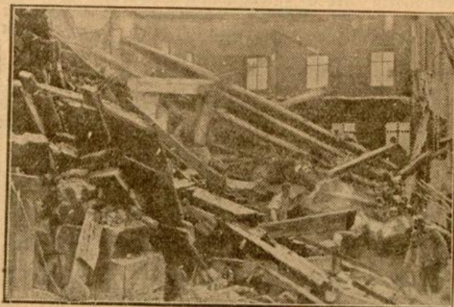
Am Schauplatz der Einsturzkatastrophe in Winterbach.
