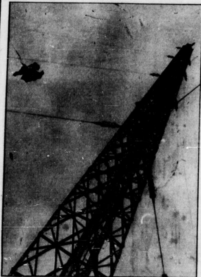
Schweres Montagearbeit in Hohlblechbauweise
