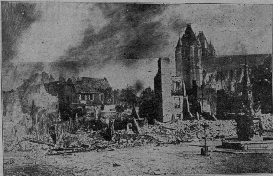
Wie der Franzose seine eigenen Städte zerstört: Das unter schwerem französischen Feuer liegende Hoya.
