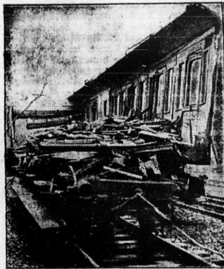
So sah der Unglückszug des Ruhrschneidzuges nach Hamm nach den Aufräumarbeiten aus. In ihm kamen 15 Menschen um.
