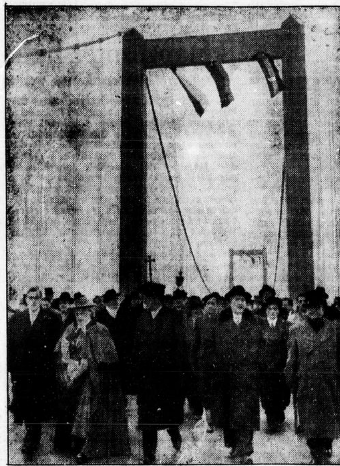
Europas größte Hängebrücke
