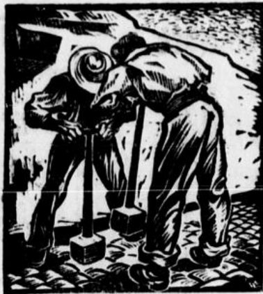
Straßenarbeiter Holzschnitt von Rudolf Warnecke
