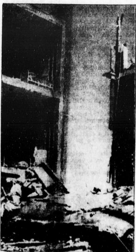
DAS ZERSTÖRTE ORLEANSVILLE Unser Teletext zeigt die zerstörte neue Schule in der vom Erdbeben heimgesuchten algerischen Stadt Orléansville.
