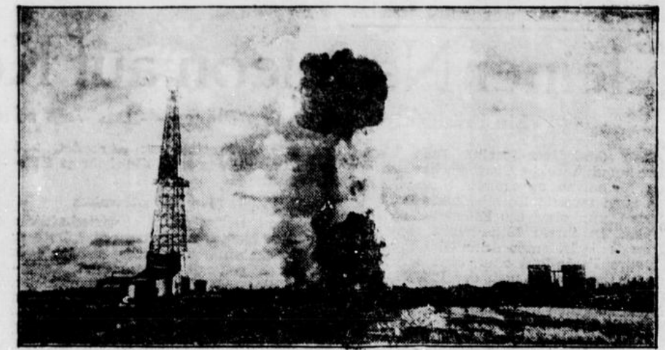
Wieder stößt eine Bohrung auf Öl. Das mit Bohrschlamm, Wasser und Chemikalien vermischte erste Öl wird in eine Grube geleitet und verbrannt, weil es sonst die Sammel tanks verschmutzen würde.
