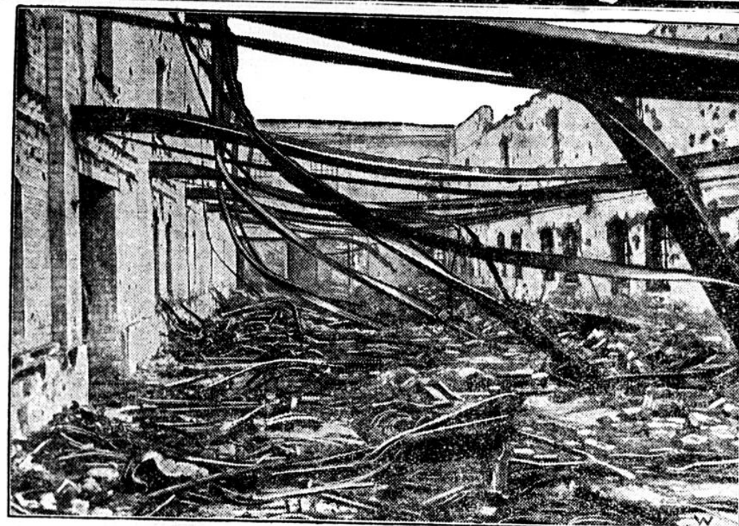
Chemische Fabrik Calbe an der Saale gänzlich eingestürzt.
