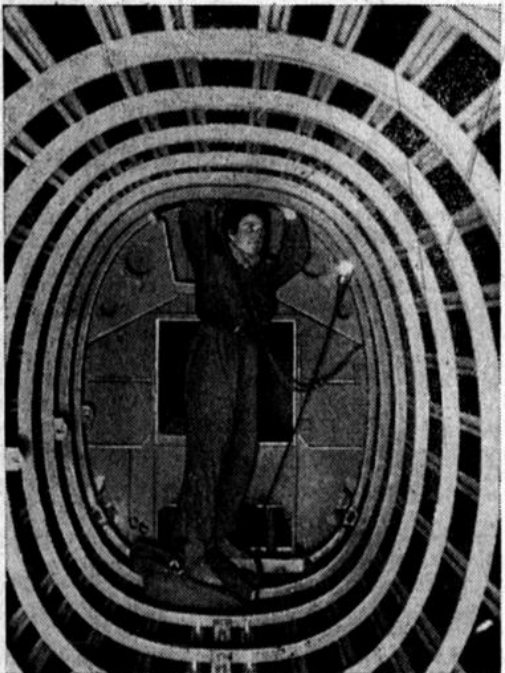
Aus den Werkstätten unserer Heinkel-Maschinen. Zu den Flugzeugen, die immer wieder im Munde der ganzen Welt sind dank ihrer einzigartigen Erfolge im Kampf gegen England und Frankreich, zählen die Heinkel-Maschinen. Unser Bild zeigt ein Beispiel für die Schalenbauweise moderner Heinkel-Kampfflugzeuge. Man erkennt deutlich den Spananten und die darüberliegenden an der Längsrichtung des Rumpfs verlaufenden Pfetten.
