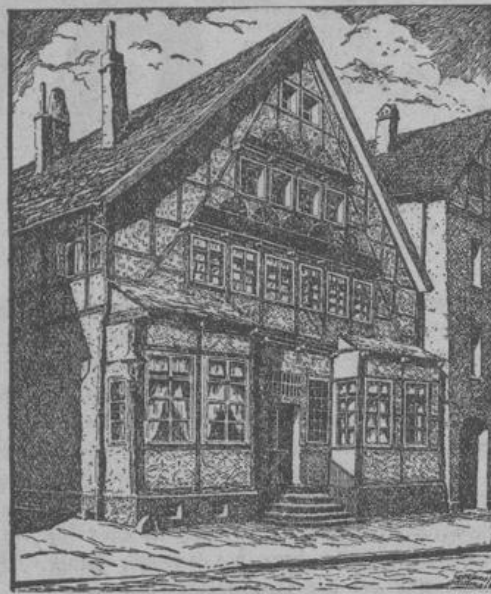
Altes Fachwerkhaus in Detmold
