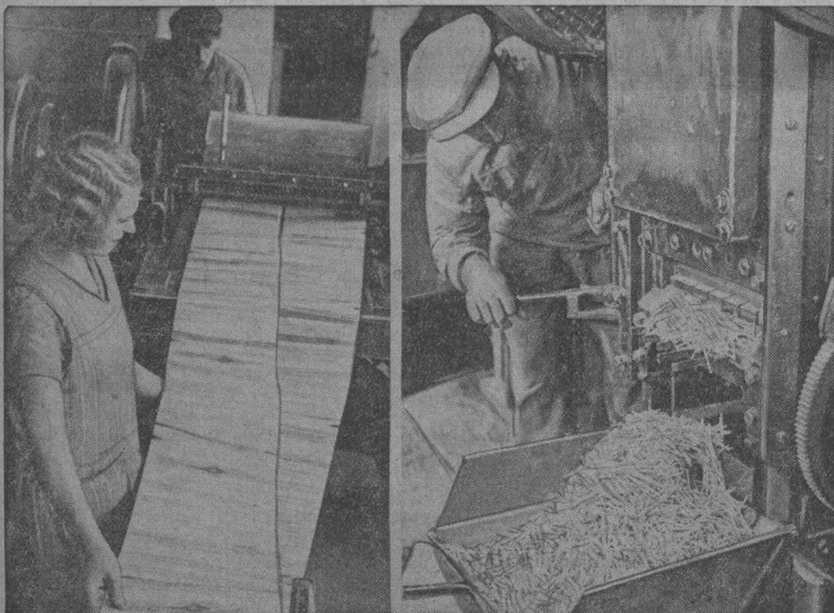
Links: In der Schälmaschine werden die Rohklötzer in etwa 3/4 Meter lange Bänder aufgeschnitten, die genau so dick sind wie das Streichholz. — Rechts: Aus den dünnen Holzbändern werden die Streichhölzer gestanzt
