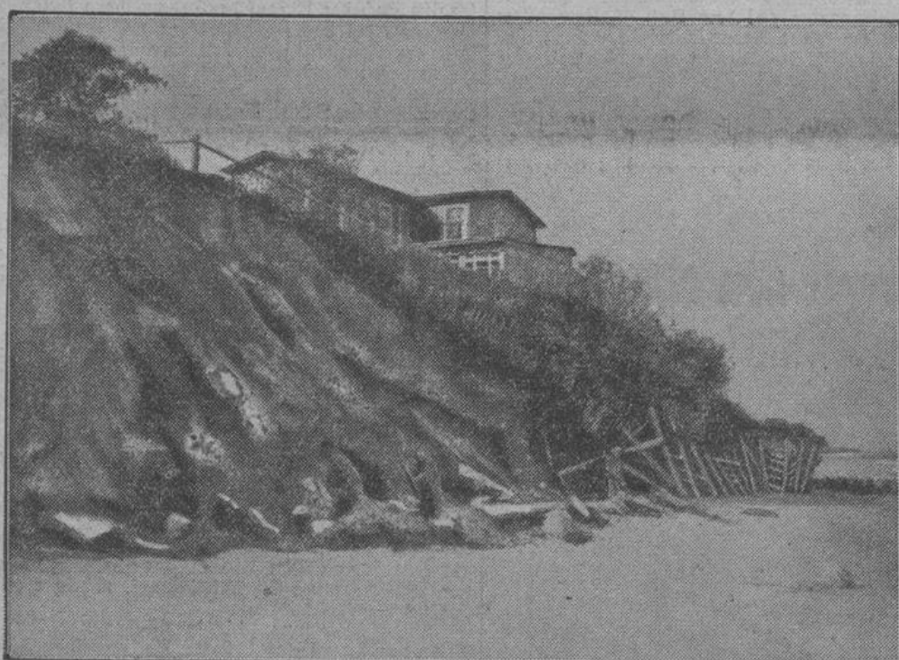
In den letzten Tagen wurden die Badeorte und Fischerdörfer in der Swinemünder Bucht von schweren Nordoststürmen heimgesucht. Am Streckberg bei Roserow auf Ubedom rissen die Wellen große Erdmassen von der Steilküste hinweg. Man verliert leicht, wie man auf unserm Bild sieht, durch Abflutungen neuen Stürmen vorzubeugen.
