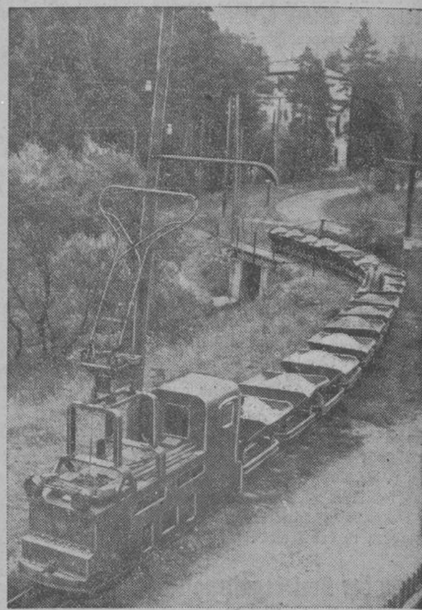
Eine Kleinbahn befördert das Golderz zur Kläranlage.
