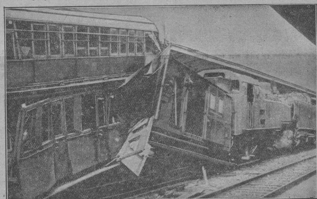
Die Trümmer des verunglückten Vorortzuges in Paris. Auf dem Pariser Ostbahnhof fuhr eine Rangierlokomotive auf einen in der Halle stehenden Vorortzug auf, wodurch 30 Waggons des Zuges zertrümmert wurden. Man sieht hier einige der zerstörten, zum Teil zweistöckigen Wagen, die noch aus Holz gebaut sind.
