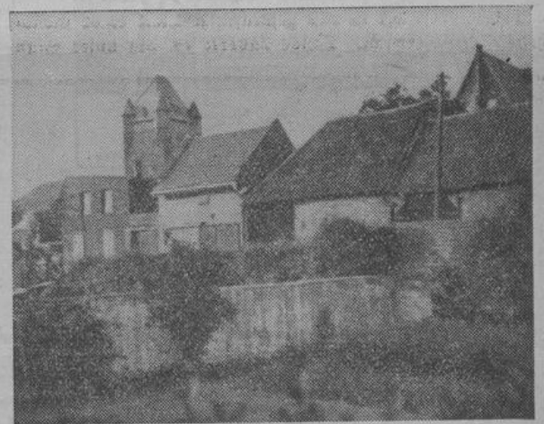
Partie an der Stadtmauer
