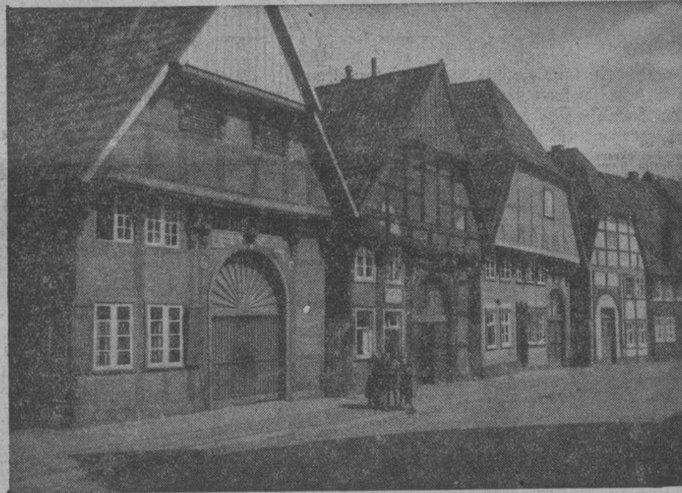
Geschnitzte Fachwerkhäuser in der Langestraße
