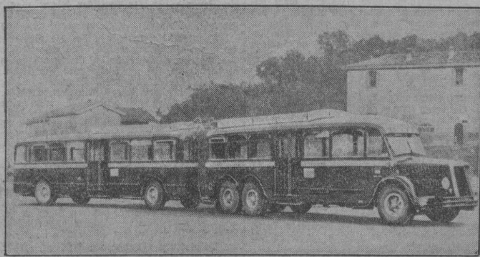
Die Motorisierung des Verkehrs hat in Italien einen neuen Fortschritt erzielt. Für den großen Fernverkehr bauen die Alfa-Romeo-Werke neuartige Autotriebwagen — die übrigens mit deutschen Dieselmotoren ausgerüstet sind —, deren einzelne Wagen miteinander verflochten und durch Durchgänge verbunden werden.
