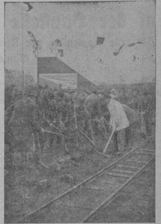
Bei Gelsenkirchen-Buer wurde am Mittwoch die Arbeitsschlacht des Gaues Westfalen-Nord eingeleitet. Unser Bild zeigt die neuangelegten Reichsautobahnarbeiter bereits eifrig an der Arbeit.
