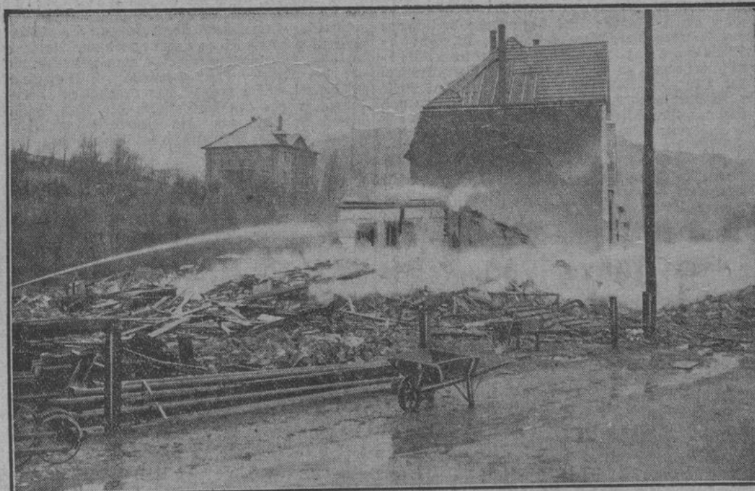
Die Trümmer des infolge einer Gasexplosion in sich zusammengebrochenen Hauses.
