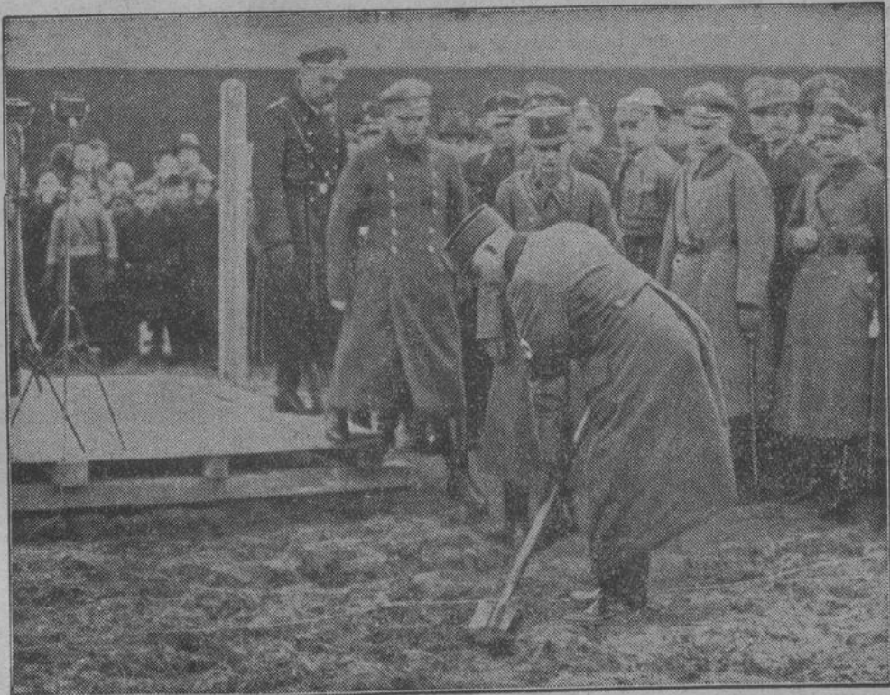
Der preußische Justizminister Kerrel beim ersten Spatenstich in Jüterbog.
