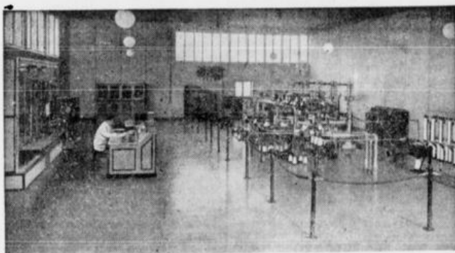
Ein Blick vom Schallpult über den ganzen Sender. Rechts ist das in Zeichnung-Entwurf des Langenberg-Senders. Links ist das Schallpult mit den verschiedenen Schaltern, die die Wellenlänge des Senders steuern.
