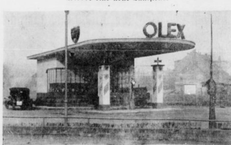
An der Kreuzung Verbands- und Herner Straße ist nun wieder eine neue Tankstelle in Betrieb genommen worden. Man hat sich jetzt der Konkurrenz gegenüber niedergelassen.
