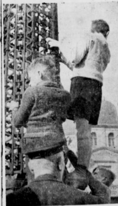
Von der lustigen Höhe eines Brückenbalkens bot sich ein besonders günstiger Ausblick.
