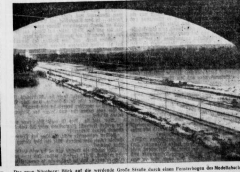
Das neue Nürnberg: Blick auf die werdende Große Straße durch einen Fensterbogen des Modellabschnitts der Kongreßhalle.
