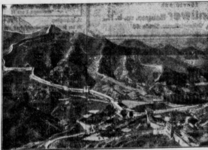
Der Nankai-Bahnhof, an dem sich die erste große chinesisch-japanische Schlacht abspielte. Der Nankai-Bahnhof mit der Straße von Peking in Richtung Kalgan (auf dem Bild nach rechts). Der Weg durchschneidet hier die alte Festungsanlage, die berühmte Große Mauer. (Spezial-Bilderdienst-DR)
