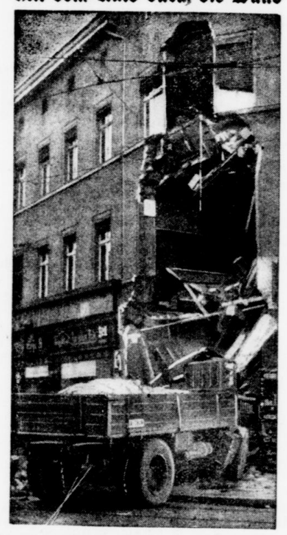
Ein nicht alltäglicher Unfall ereignete sich in Berlin-Weißensee, bei dem ein Lastauto einen großen Teil einer Hausfront einbrachte. Zum Glück kamen bei diesem Unfall keine Menschenleben zu Schaden. (Scherl-Bilderdienst-M.)
