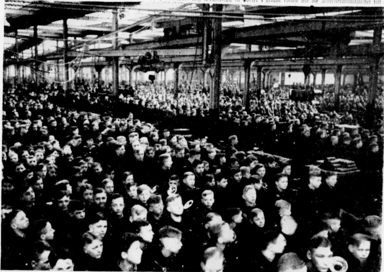
Blick in die Maschinenhalle bei Gidhoff.
