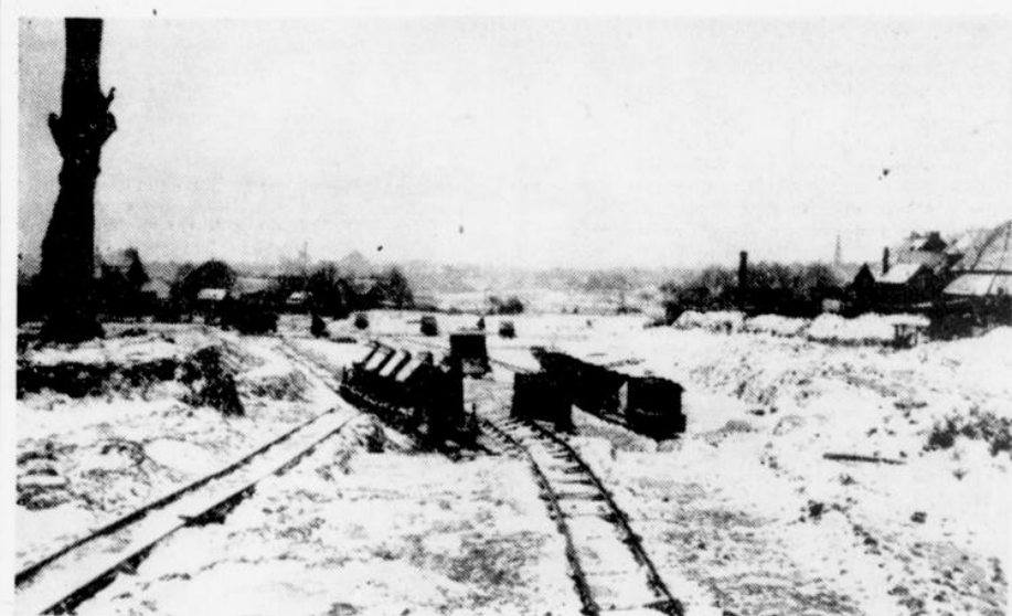
Blick von Seiers Büschchen auf die Arbeiten an der verlängerten Königsallee zwischen Berner- und Marktstraße. Im Hintergrund die Dammanfüllungen im Wiefental
