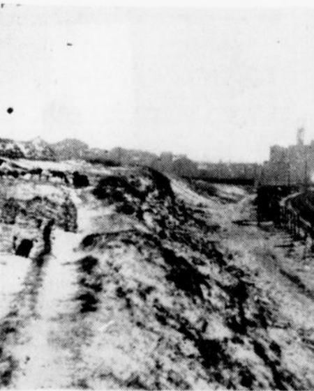
Die Bahnlinie der Staats-Eisenbahn Weimar-Langendreer, die im Zuge der verlängerten Königsallee überbrückt werden muß. Rechts die gewal- tigen Dammanfüllungen, um das Wiefental zu überqueren. — Im Hintergrund die Reihe „Brückengießer“.
