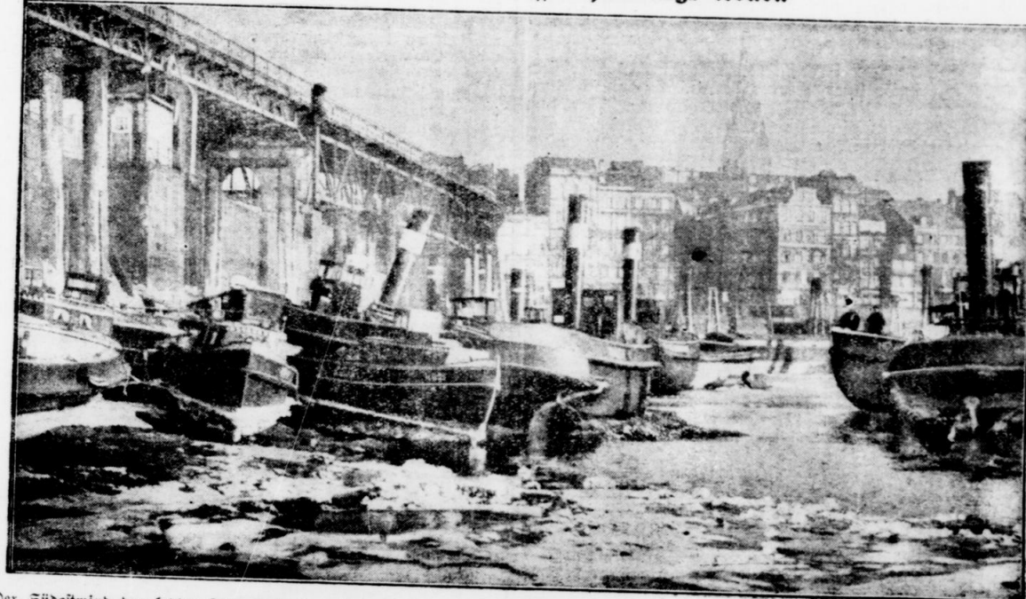
Der Südostwind der letzten Tage hatte das Elbegewässer in die Nordsee gedrängt, so daß die Gewässer Hamburgs einen Niedrigwasserstand erreichten, wie er seit Jahrzehnten nicht mehr beobachtet wurde. Teilweise wurde dadurch die Elektrizitätsversorgung der Hansestädte kitzgelegt. Ohne einen Tropfen Wasser unter sich, liegen Schlepper und Barkassen auf Grund. (Scherl-Bilderdienst-M.)
